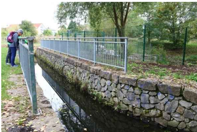
Alte Wuhle - Brückenbauwerk
