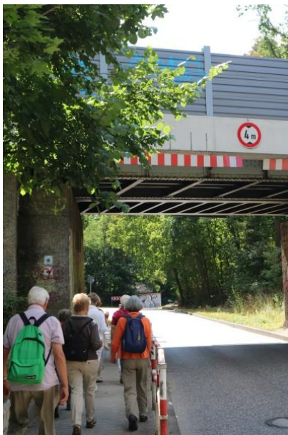
Garzauer Straße - Bahnbrücke
